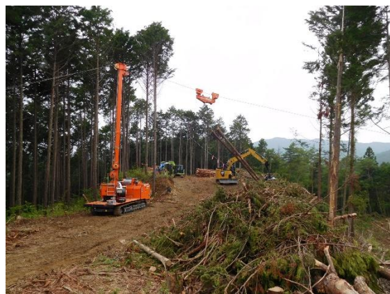
タワーヤードを活用した集材作業
