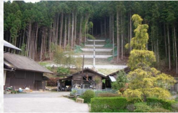
山腹崩壊防止工事
