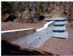
土砂流出防止工事
