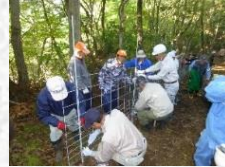
侵入防止柵設置
