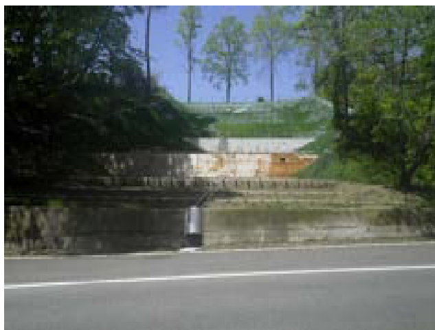
復旧工事の完了状況（那珂川町 権現山）
