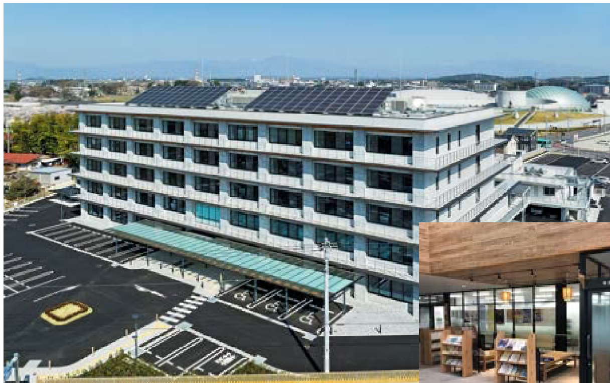
那須庁舎全景（令和5(2023)年3月供用開始）
