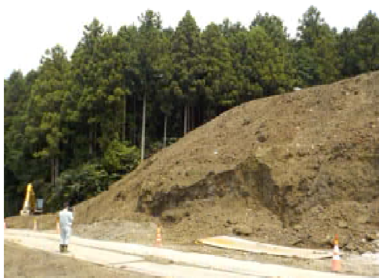
ドローンによる不法盛土の測量
