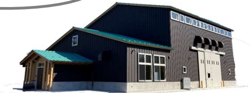
全天候型実習棟
