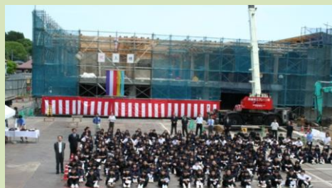
茂木中生徒全員参加による上棟式
