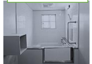
特化ユニット浴室
