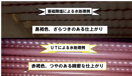
亜硫酸塩による水処理例
