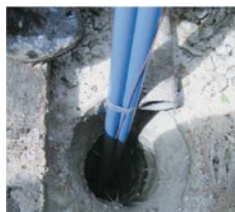
地下100m取り込み口
