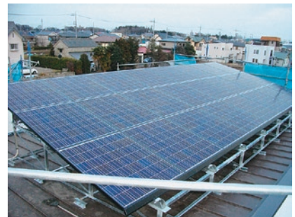
逆勾配屋根に施工 太陽光パネル設置
