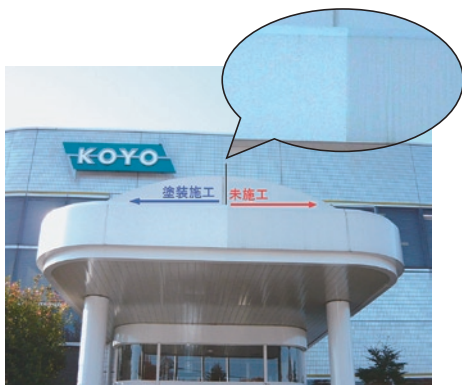
本社社屋 入口
