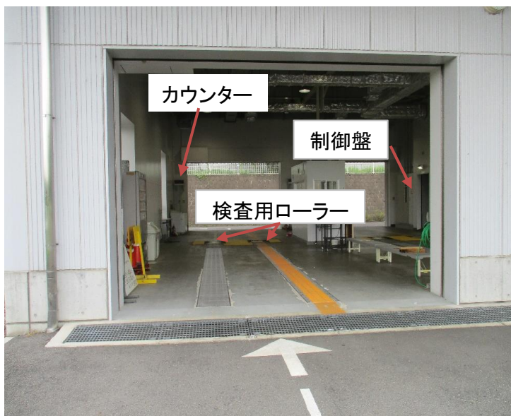
タクシメーター装置検査用基準器の設置状況
