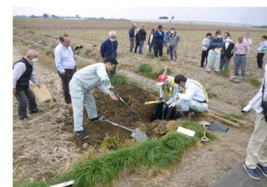
田んぼダム排水マスの設置
