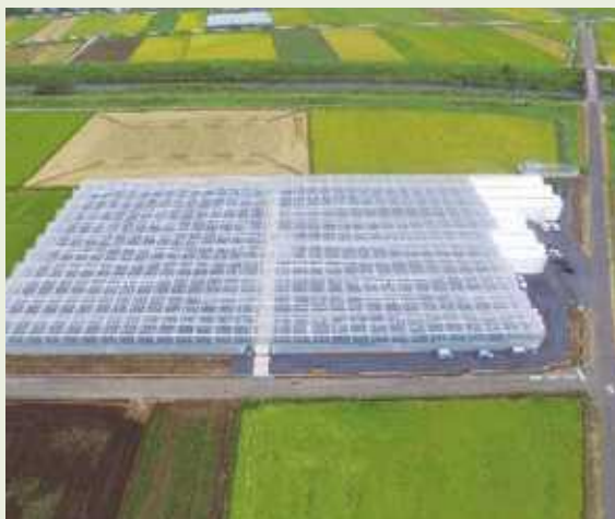
次世代トマト生産施設
