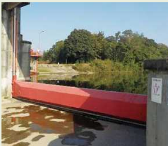
改修された洪水吐ゲート
