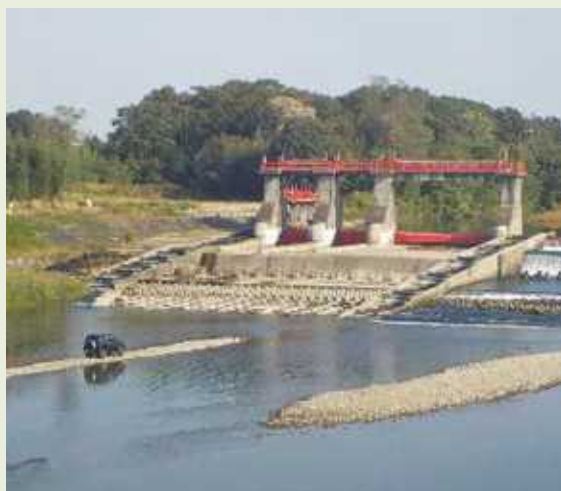
完成を迎えた美田東部頭首工
