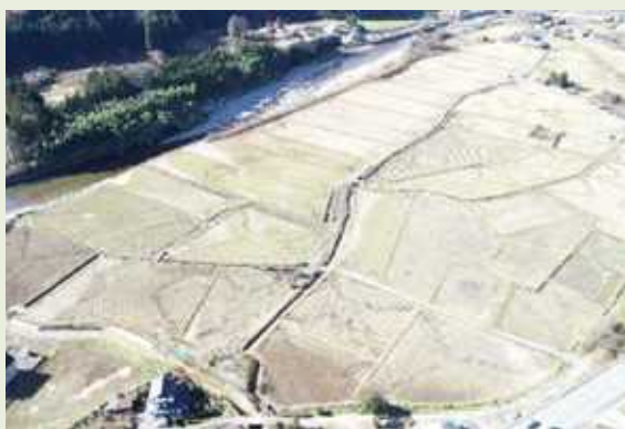
令和元年度の工事区域(引田地区)
