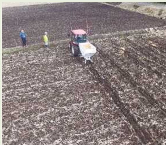
補助暗渠設置状況(2m間隔)
