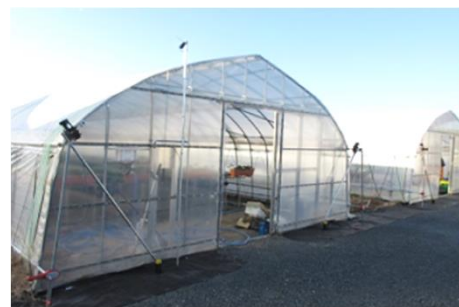
移設・修繕したいちごハウス
