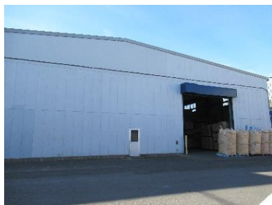
定温保管施設の全景
