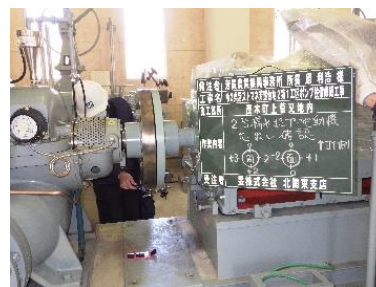
ポンプ据付確認
