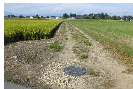
暗渠型排水路施工後
