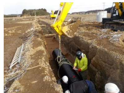
暗渠型排水路施工中
