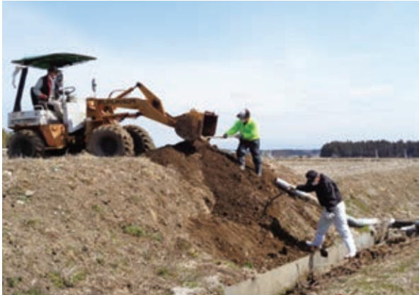
地域共同による被災畦畔の復旧作業 【宇都野環境保全会(那須塩原市)】
