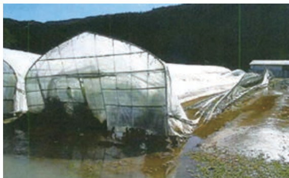
写真1 被災直後のパイプハウス
