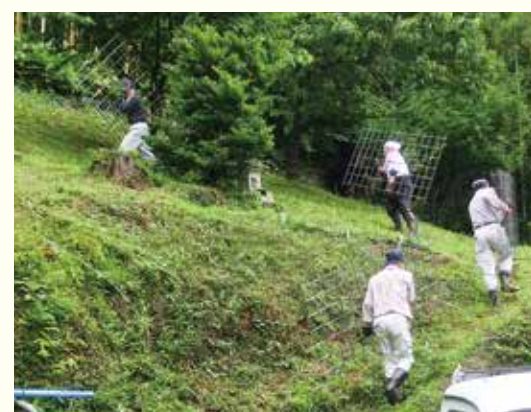
防護フェンスの運搬作業
