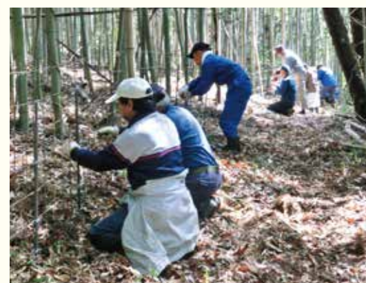
イノシシ防護柵設置作業
