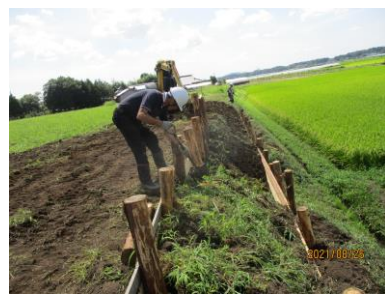
地域共同による復旧作業
