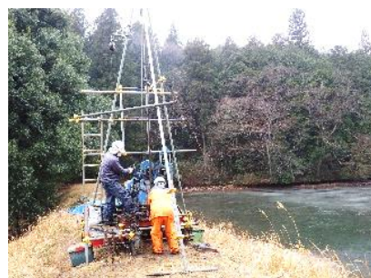
堤体地盤状況の確認 (ボーリング調査)
