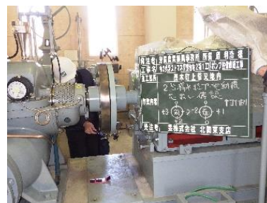
ポンプ据付確認
