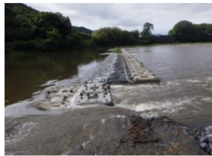
改修工事が終わった右岸側
