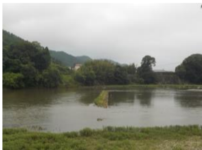
損傷を受けた境堰
