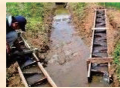
水田魚道の設置
