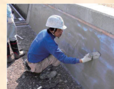
水路壁のコーティング
