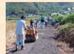
未舗装農道の舗装
