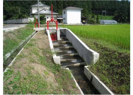
落差を斜面にし、玉石等を配置して、魚類等の遡上を助けています。
