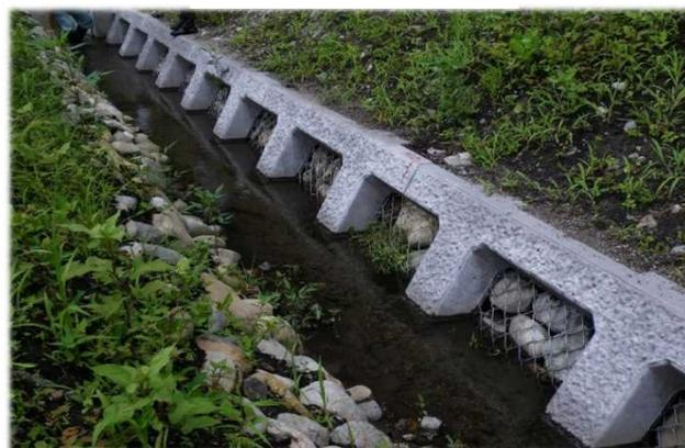
コンクリート枠に、玉石を詰めたり、ふとん籠を用いることで、多孔質な護岸構造とし、多様な生きものの生息場所を確保しています。(生きものの生息に重要な湧水などの水環境を確保する施設)
