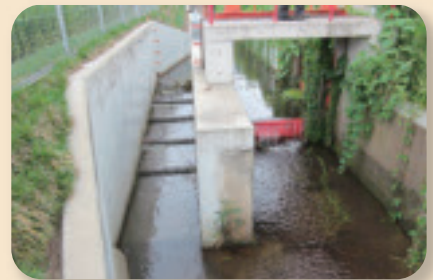
水路のネットワーク化を図る魚道の整備
