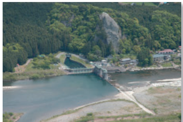
※ 県東県央の農業用水を安定供給する佐貫頭首工
