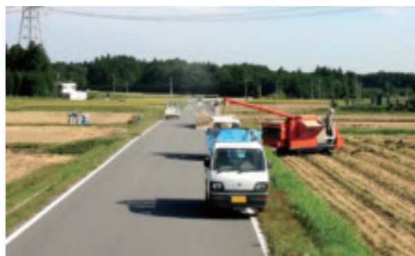
舗装されたほ場整備地内の農道
