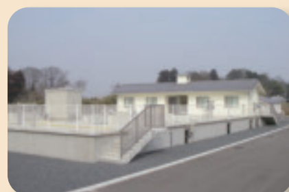
農業集落排水処理施設
