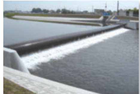
整備された取水堰（強口堰）
