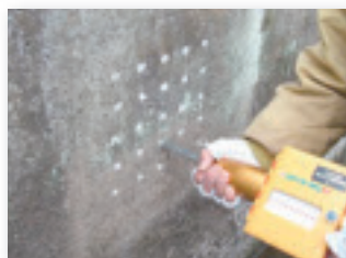
コンクリートの強度試験
