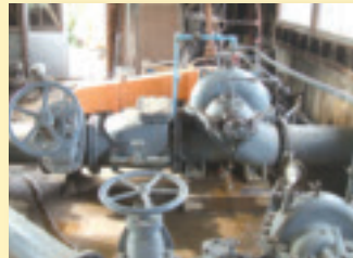
老朽化した排水機場
