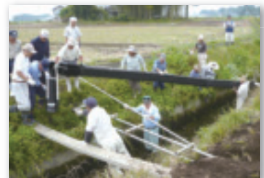
水田魚道の設置
