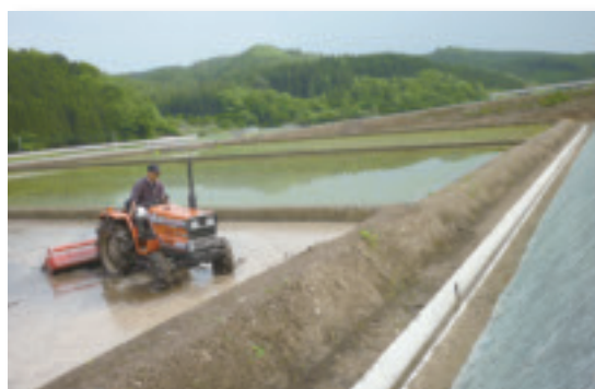
整備された中山間地域のほ場（那須町）
