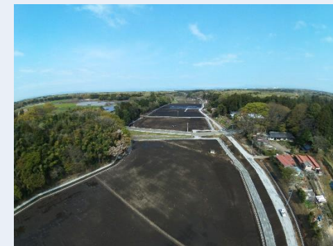
基盤整備を実施した打越新田地区
