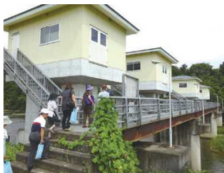
森田頭首工(那須烏山市) 生態系に配慮した魚道見学
