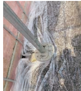
気密性向上 (隙間ができないように被覆)
