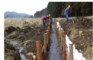
豪雨災害後の水路復旧
