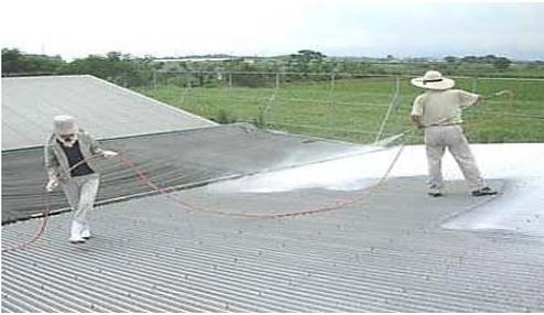
屋根への断熱資材（石灰）塗布作業
