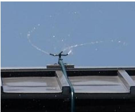
70頭規模フリーストール牛舎で4台の sprinkler を設置した事例
