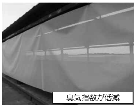
＜発酵施設への防臭カーテン設置＞
