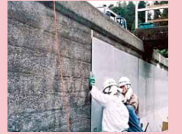
強化プラスチック版による補修
