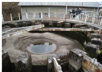
通水停止した円筒分水井
