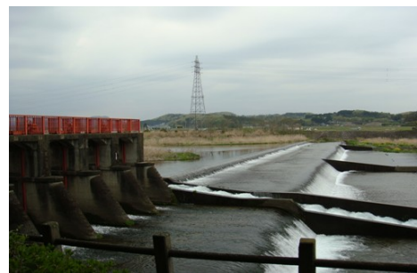
写真2 小倉堰（西方町）
