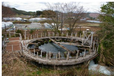
写真1 円筒分水井（日光市）
