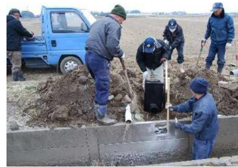
田んぼダム排水柵の設置中
