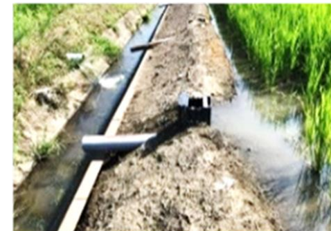
田んぼダム排水柵の設置後
