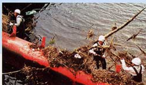
流木等撤去作業
