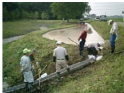
水田魚道の設置
