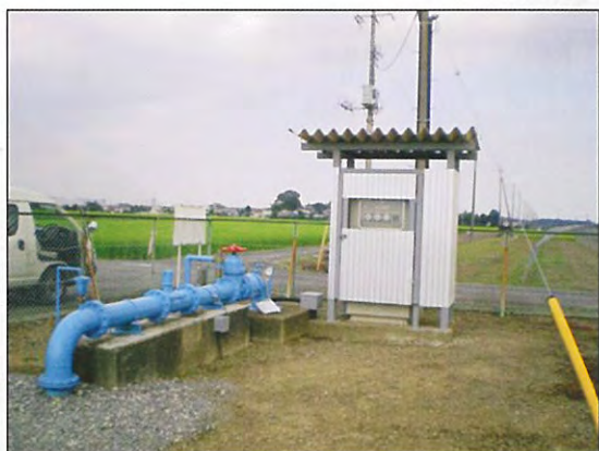
管理省力化を図る揚水機のインバータ化 (栃木市：国府南部地区)
