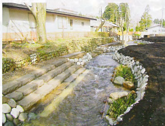
自然環境、生態系保全に配慮したうるおいのある農業用排水施設 (那須町：那須北地区)
