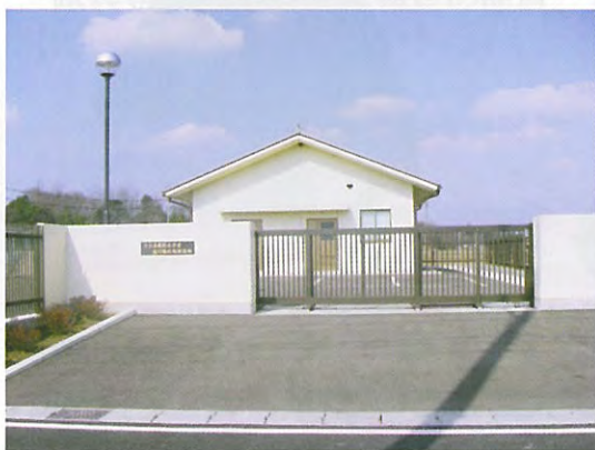
農村集落の生活排水を処理し、快適な生活環境の向上を図る農業集落排水施設 (壬生町：恵川地区)
