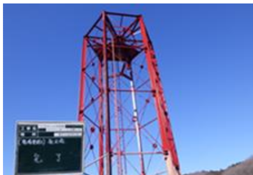
赤川ダム 取水塔塗装実施後
