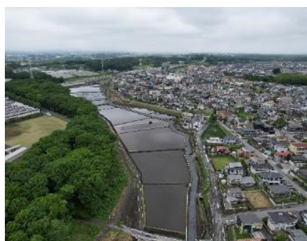
農地整備の施工状況（刈沼川）
