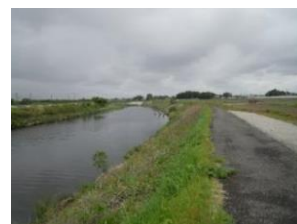
整備前の旧排水樋門
