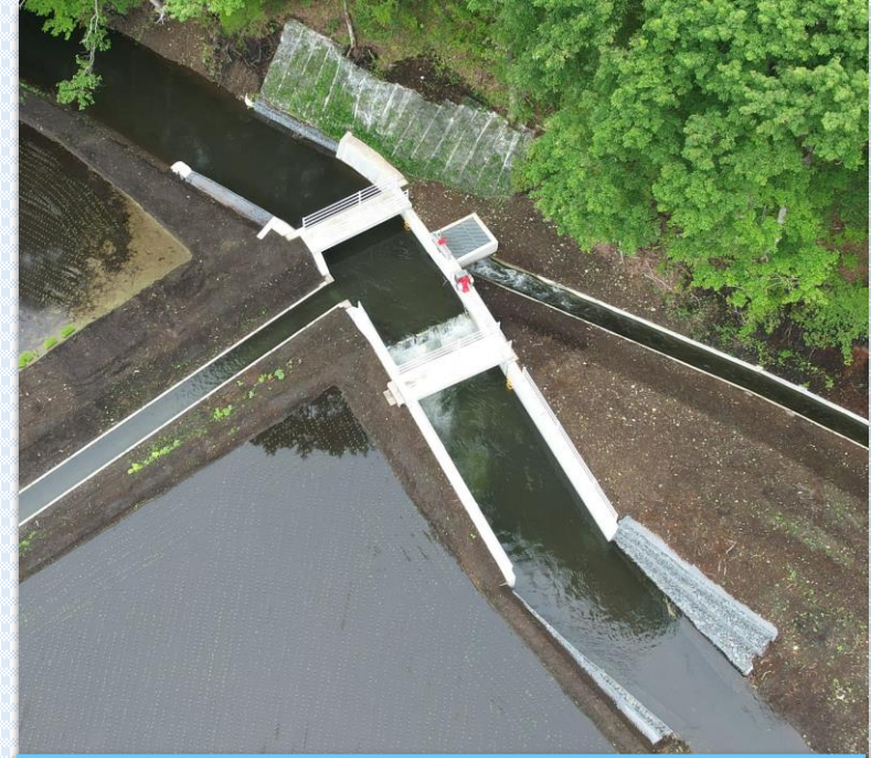
施工後(ドローン撮影)
