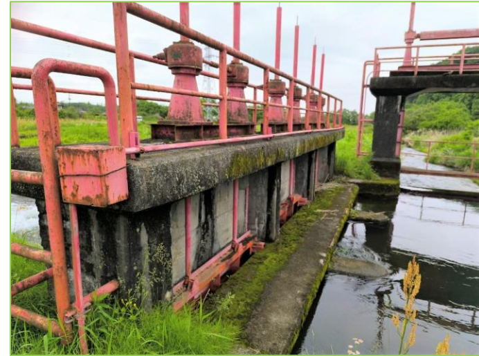
老朽化したゲート・コンクリート
