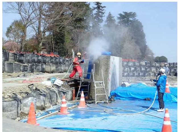
高韌性モルタル吹付のための高圧洗浄処理
