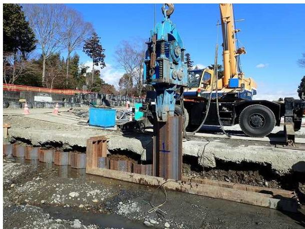
小口止の基礎（遮水鋼矢板）施工
