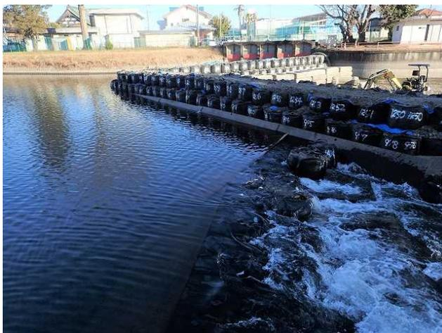
工事期間中に穴川へ取水するための仮堰の設置
