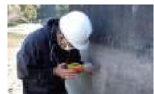
劣化状況等調査
