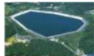
国営芳賀台地地区の塩田調整池
