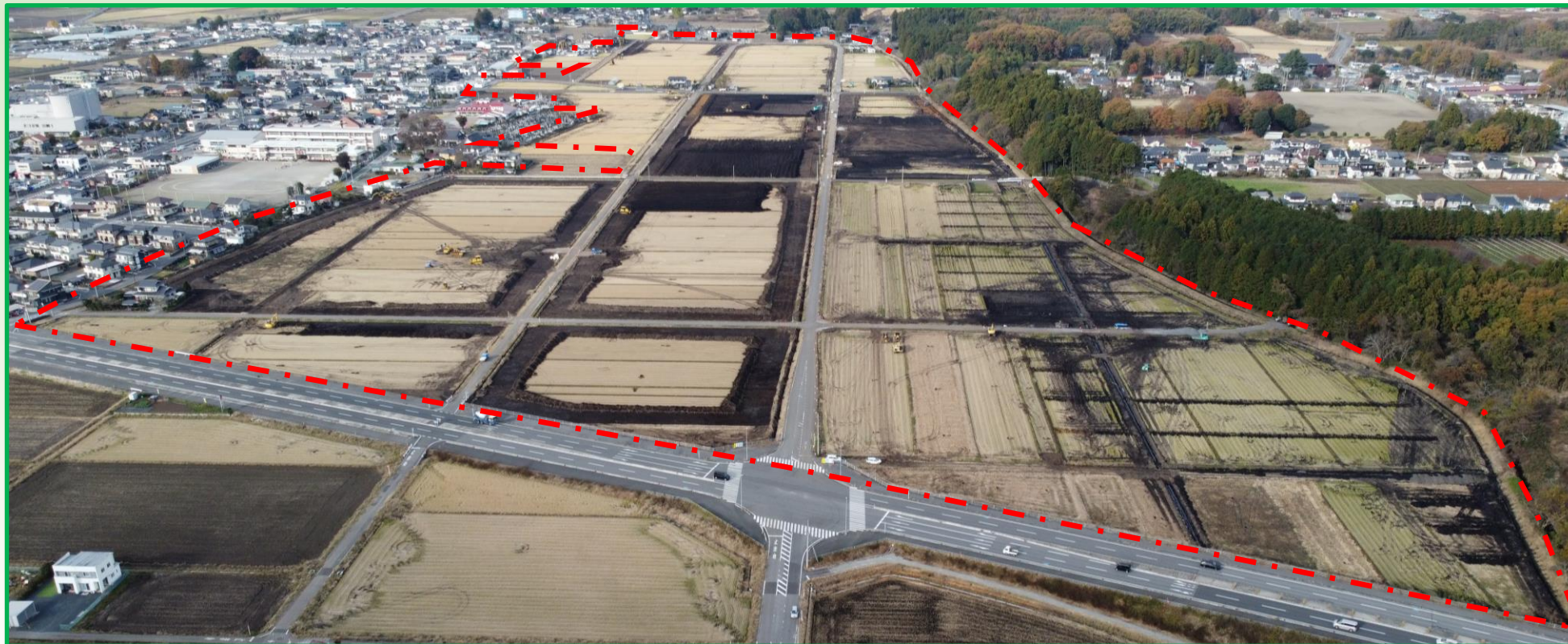
工事が進む祖母井地域の農地
