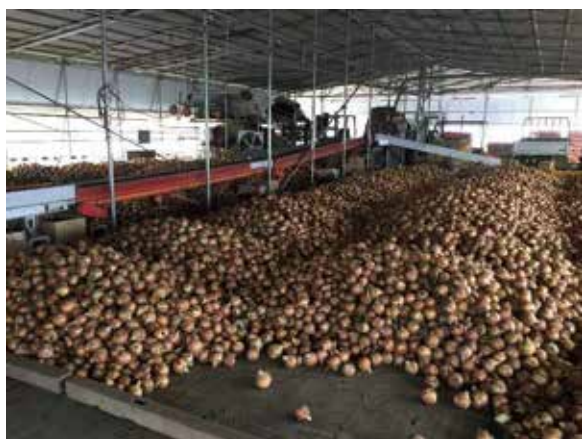
乾燥・調整施設 （コンベアー奥が選別機）
