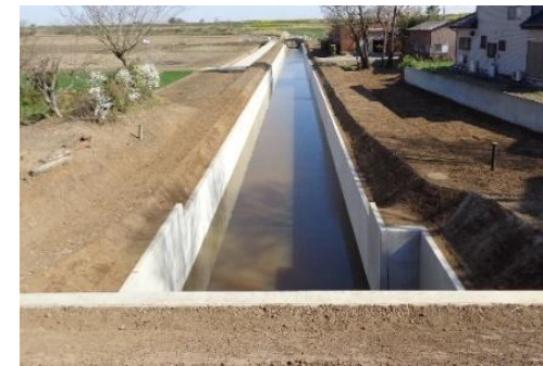
（ 排水路工事後 ）
