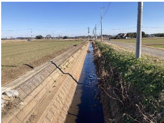
(東清水川排水路)
