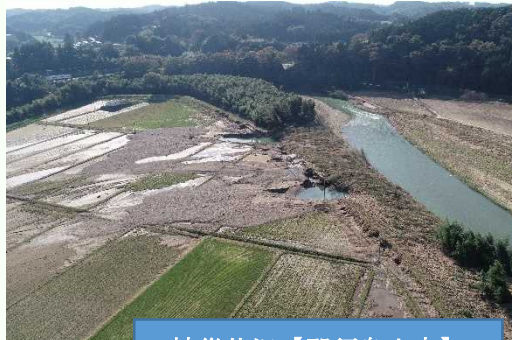
被災状況【那須烏山市】
