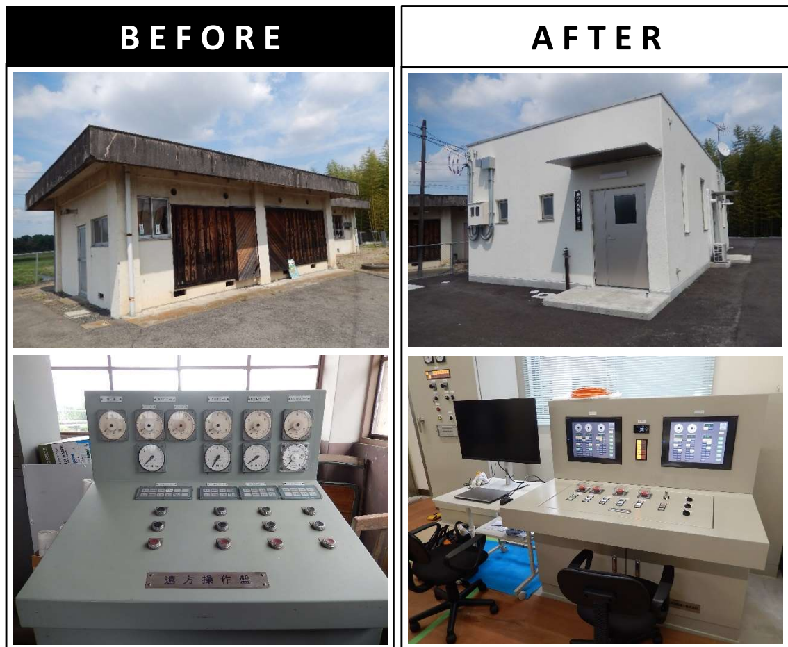
↑ 西の原頭首工管理棟及び操作システムの改修前後の比較
