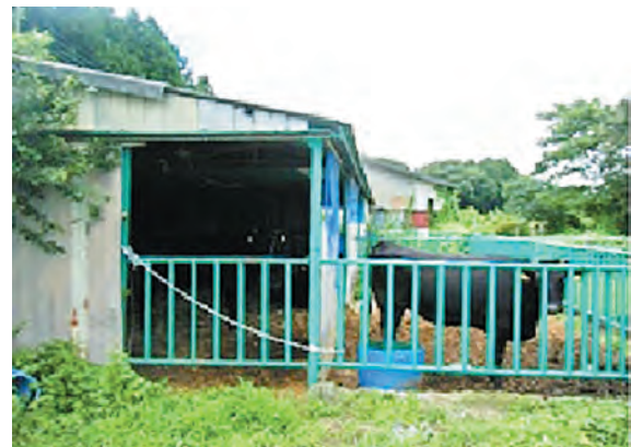
隣人の農家より借用し、DIYで修繕した牛舎
